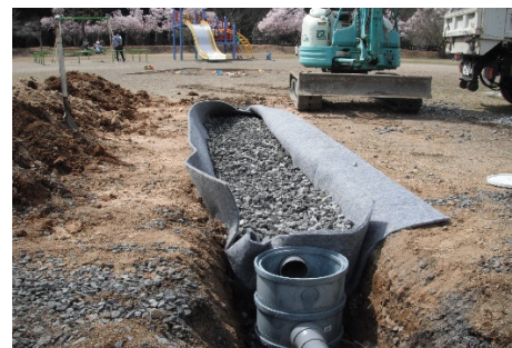
清掃柵及び浸透柵設置
