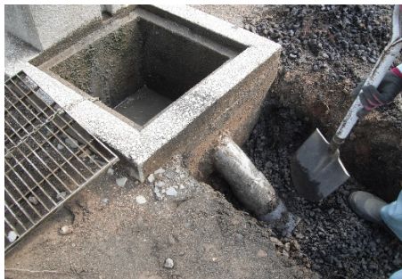
掘り出し作業
